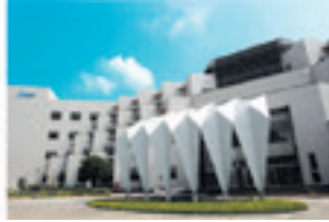
台南研發中心 (鑽石級綠建築)
