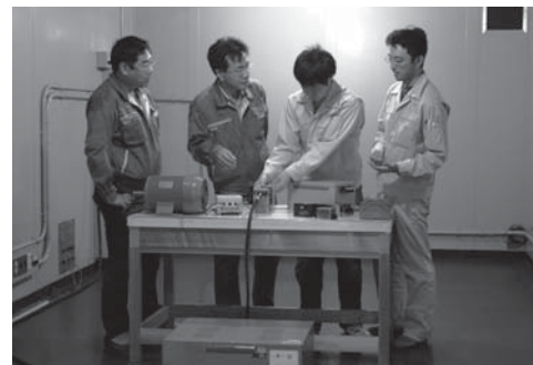
EMIシールドルーム(長野県岡谷市)
