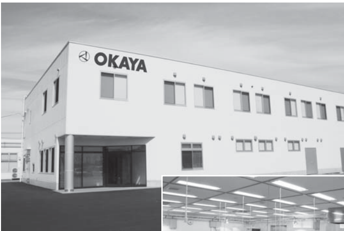
サージ試験棟(埼玉県行田市)
